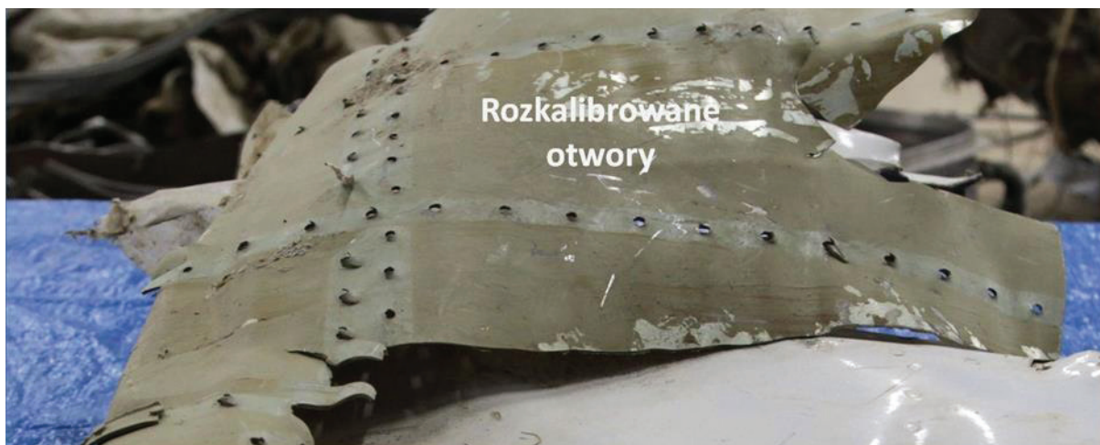
Rys. 2.190 Odlamek poszycia strefy „K” grzbietowego pasa dachu, znajdujący się w konstrukcji Tu-154M między wręgami 59–61 i podłużnicami 0–5P, nad przedziałem ogólnopasażerskim. Widoczne są liczne rozkalibrowane i porozrywane otwory po przecięnięciu się przez nie główki nitów z oderwanych wręg i podłużnic
