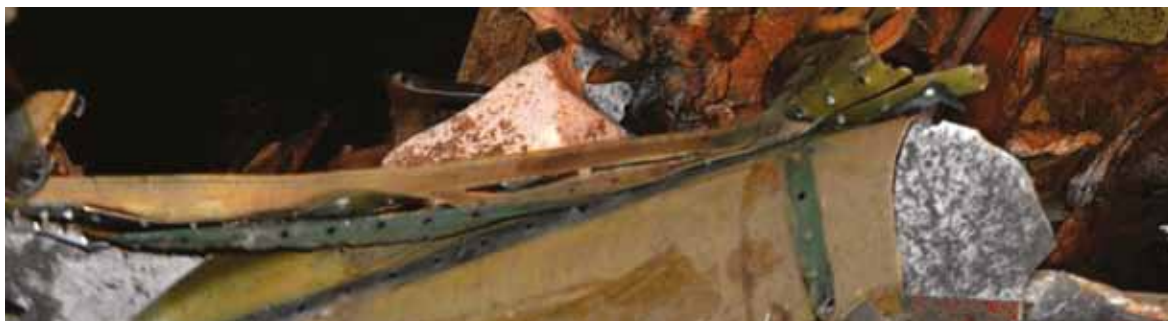
Wywinięte na zewnątrz poszycie fragmentu „B” bocznej burty salonki prezydenckiej. W prawym dolnym rogu widoczny czerwony pas malowania podokiennego. Widoczne oderwane od poszycia usztywnienia poprzeczne i podłużne. Brak materiałów izolacji termicznej.
